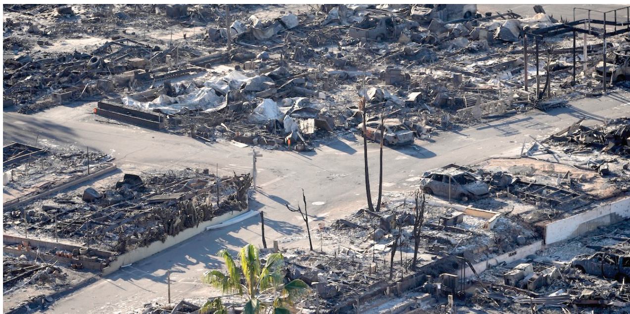
El complejo de apartamentos Pacific Palisades Bowl Mobile Estates destruido por el incendio Palisades en el vecindario Pacific Palisades de Los Ángeles, el jueves 16 de enero de 2025. (Foto AP/Damian Dovarganes). The Pacific Palisades Bowl Mobile Estates apartment complex destroyed by the Palisades Fire in the Pacific Palisades neighborhood of Los Angeles, Thursday, Jan. 16, 2025.
